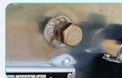
Extra 3/4" matningsanslutning för direktkoppling mot maskin
