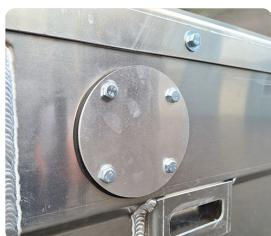
Öffnung für Schlauchdurchführung (abgedeckt) für Dauerbetrieb betrieb von Kraftwerken und Generatoren.
